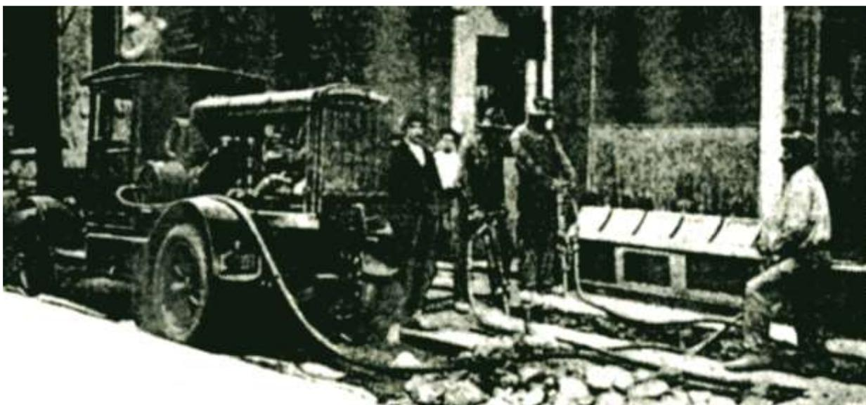
**Ремонт мостовой с использованием компрессора на автоходу**
