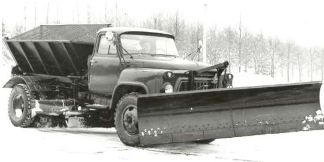
**Плужно-щёточная машина с пескорасбрасывающим оборудованием на шасси ГАЗ-53**
