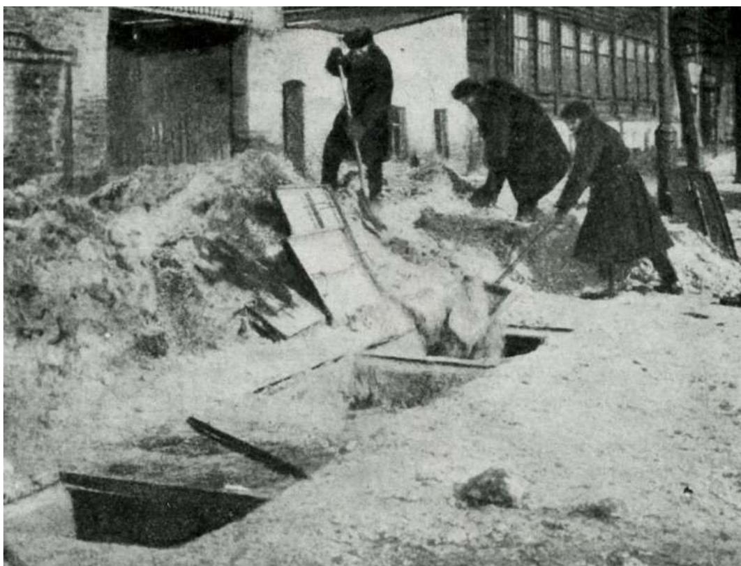
**Стационарная снеготаялка инженера Д.В.Домашнева при банях на Библиотечной улице – люки для загрузки снега.**
