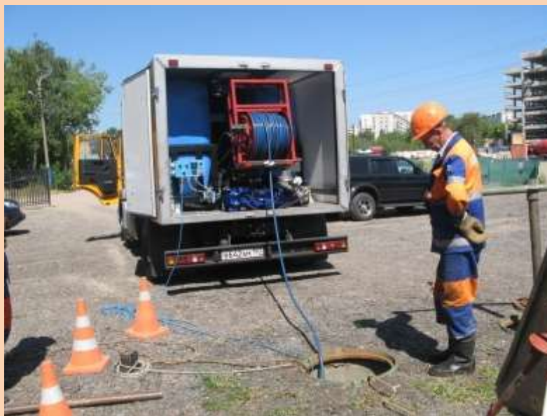
Рис.1. Машина ДКТ-275В во время профилактической прочистки канализационного трубопровода
